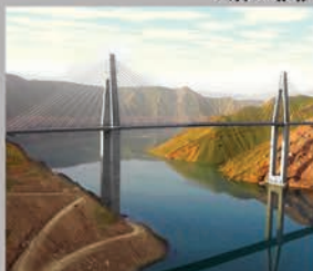
پل کابلی لاری
