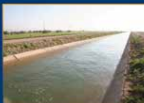
کانال اسنی دشت عباس (استان ایلام) dast-e-Abbas south zone channel (Ilam province)
