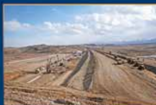
عملیات اجرای سد تپ (استان قزوین) nabeh dam (ghazvin province)
