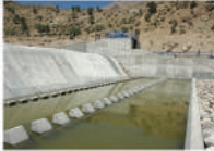
شبه های آبیاری و رهگنی پایه ۳
